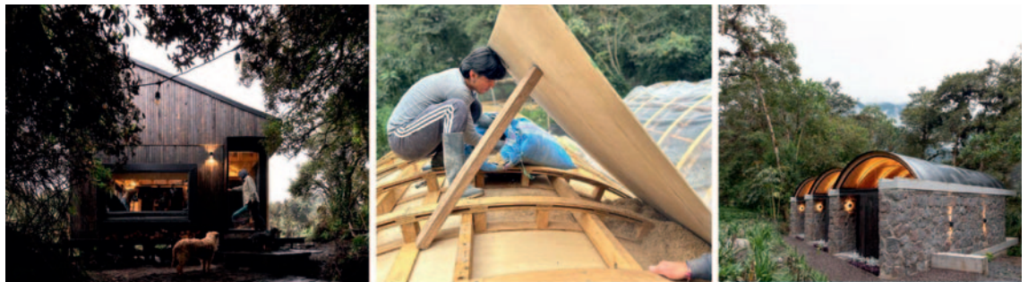
Figura 2: Izquierda, Foto Arrachay 01, con uso de BIOM en todo el envoltorio. Centro, colocación BIOM al granel. Derecha, Foto Las Pajareras, con uso de BIOM en cubierta.
