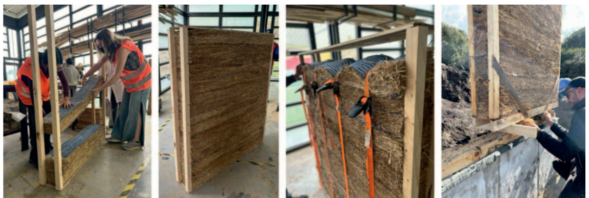
Figura 3: De izquierda a derecha: 1.Pre Fabricación artesanal en taller. 2.Panel entero. 3.Compresión adicional. 4.Instalación en obra, previo del panel sin revoco de tierra.
