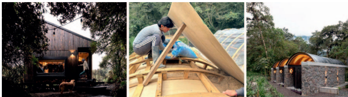
Figure 2 : À gauche, photo Arrachay 01, avec BIOM utilisé sur l'ensemble de l'enveloppe du bâtiment. Au centre, BIOM appliqué en masse. À droite, photo Las Pajareras, avec BIOM utilisé sur le toit.
